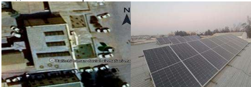
Рис.4. Спутниковый снимок с видимым расположением СФЭС мощностью 10 кВт на крыше единого окна Хатырчинского района.
