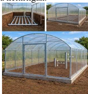
1-rasm. Tuproq osti issiqlik akkumulyatorli issiqxona va issiqlik almashinuv qurilmasining konstruktiv tuzilishi.
