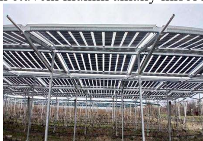
3-rasm. Quvvati 50 kVt bo'lgan Sirdaryo viloyatida joylashgan agrofotoelektrik tizim
