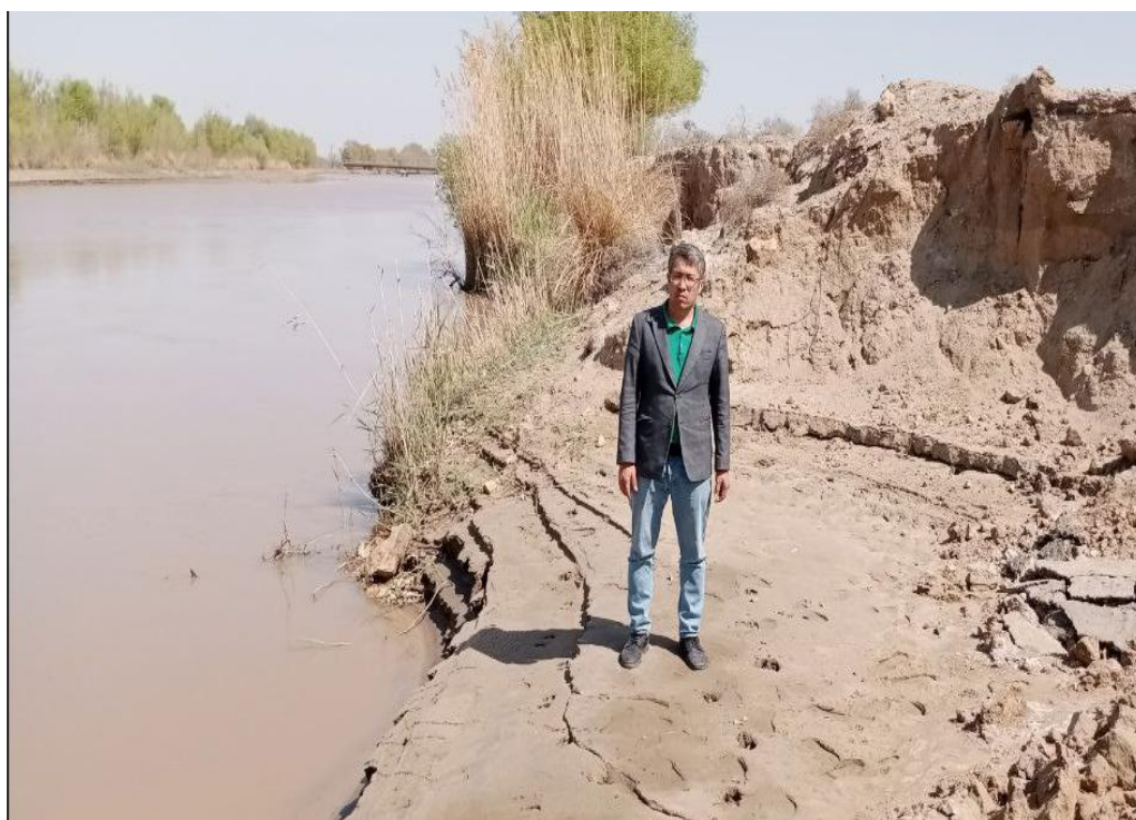
2-rasm. Amu-Buxoro mashina kanali PK1099 piketida yuvilish holati.
